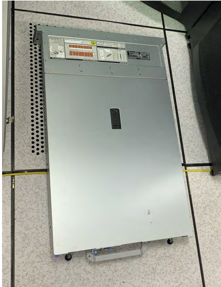
รูปที่ 2-198 ภาพอุปกรณ์เครื่องแม่ข่าย พร้อมดำเนินการติดตั้ง
